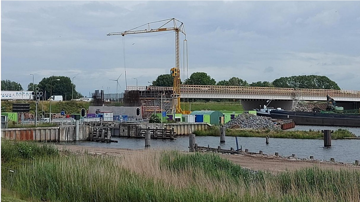
Nieuwe brug in aanleg (juni 2022)
